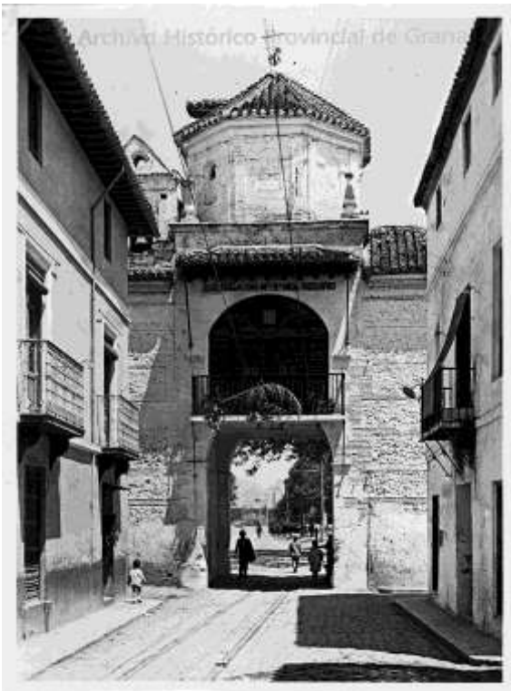
Ilustración 02. Fachada sur de la Puerta de Granada asociada a la petición de subvención al Ministerio de Instrucción Pública y Bellas Artes para la reconstrucción del Arco de Loja en 1930 (Archivo Histórico Provincial de Granada. Signatura F-97).
