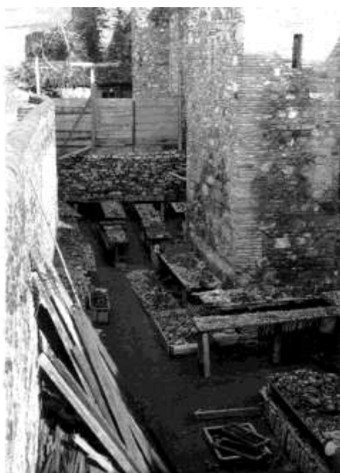
Ilustración 02. Intervención de consolidación de paramentos en la Alcazaba de Málaga. Proyecto de restauración dirigido por de Torres Balbás. Fondo Juan Temboury Álvarez. Diputación de Málaga.
